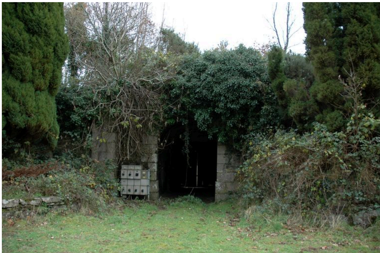
Vue du fort de Penfeld : le passage d'entrée
