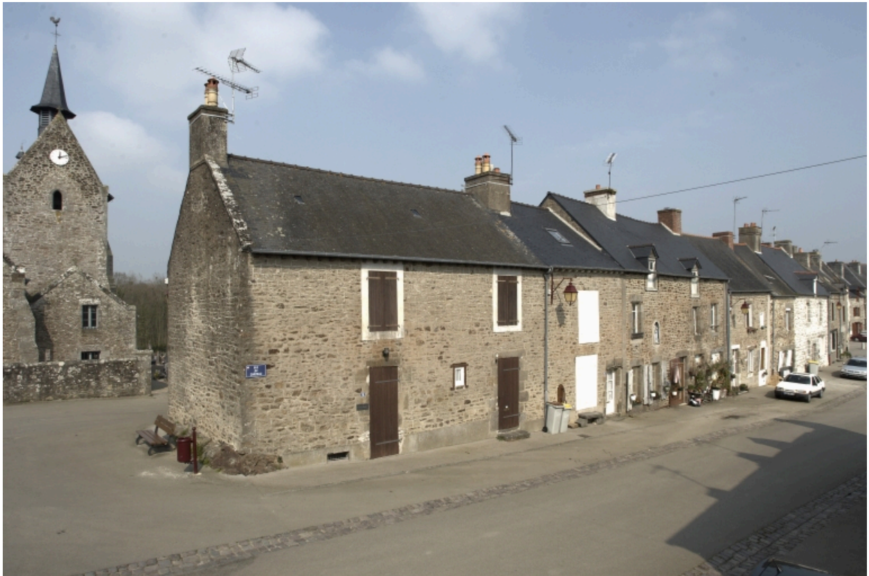
Vue de situation sud-est
