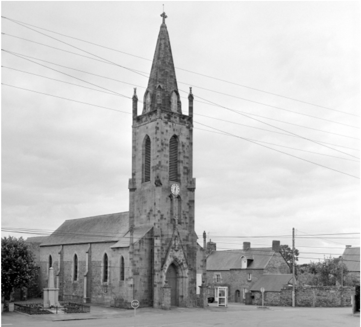
Élévation nord-ouest : vue générale
