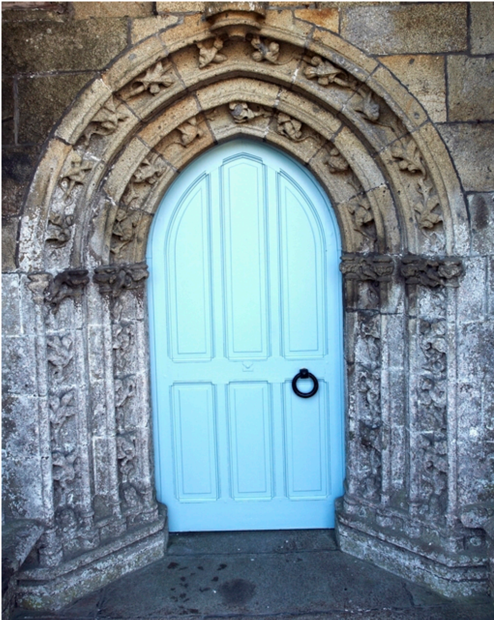
Intérieur du porche nord, porte de la chapelle.
