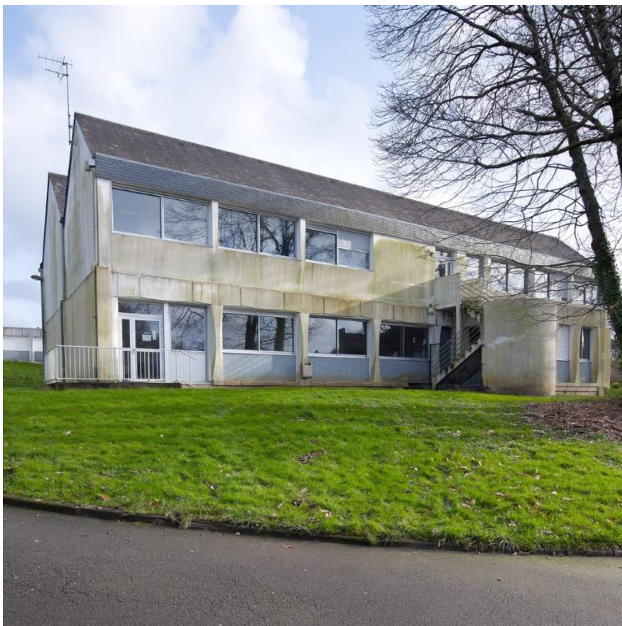
Façade nord-ouest du bâtiment A3 (rez-de-chaussée, Yves Guillou, architecte, 1980 ; surélévation et escalier de secours construits ultérieurement).
