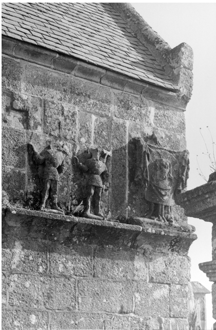
Façade nord, frise : détail des groupes à l'ouest
