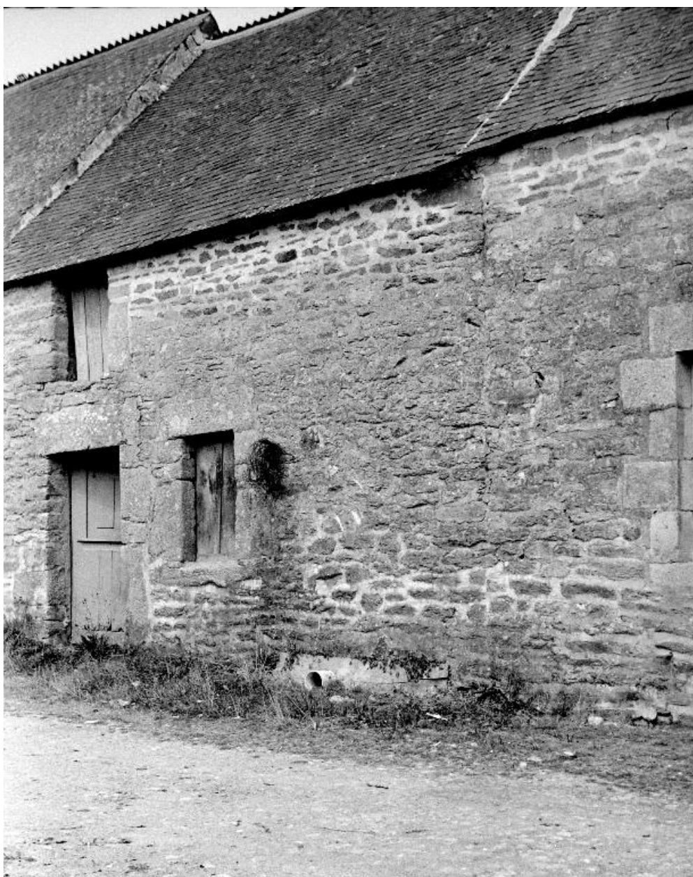
Ferme 48 (état en 1969)
