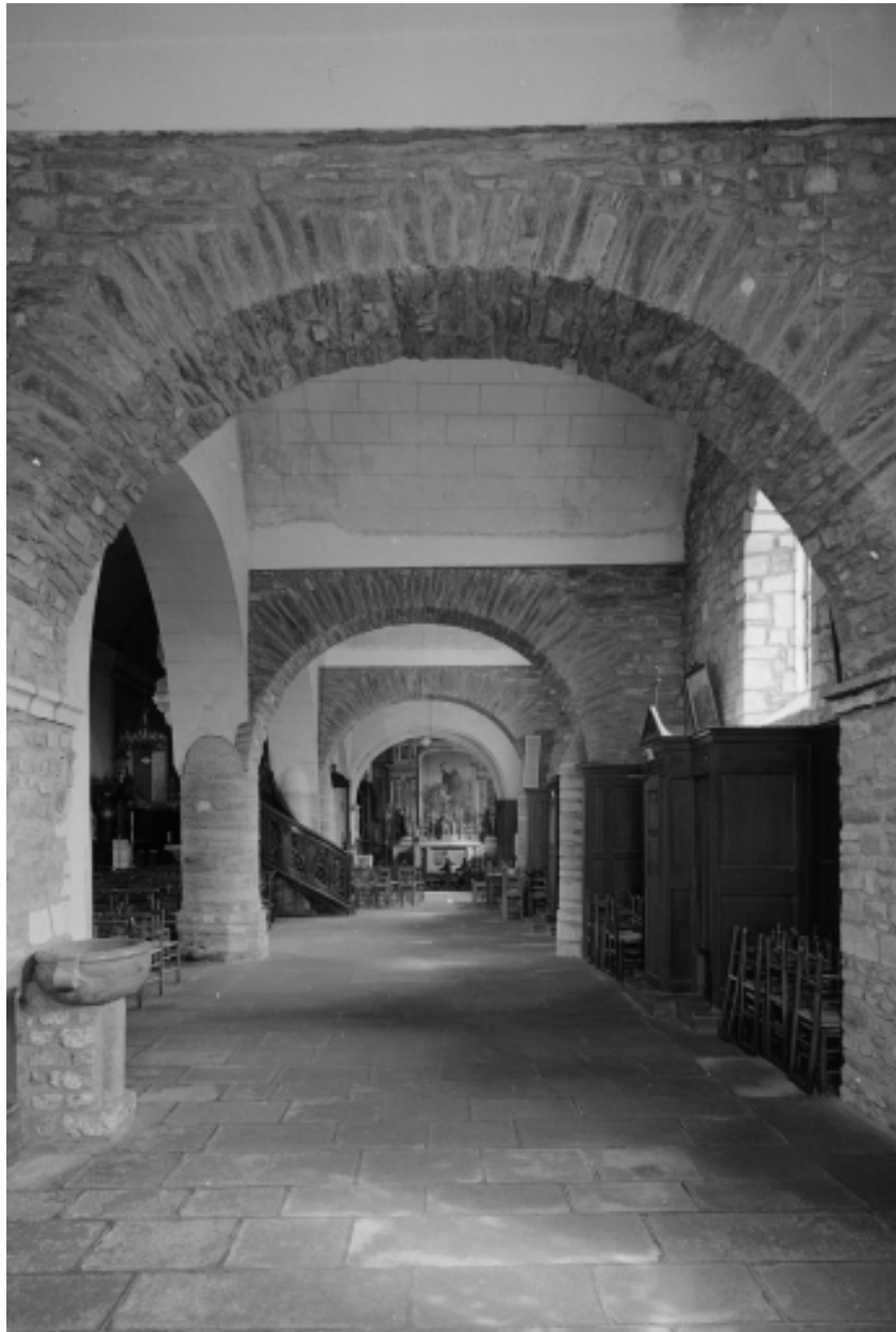
Vue générale axiale bas-côté sud (ouest-est).
