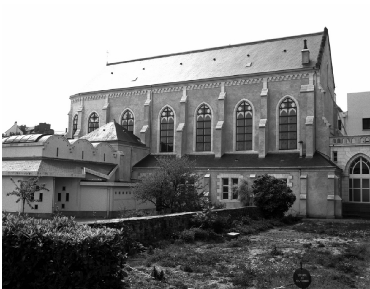
Vue générale de la chapelle vers le sud avec vue de la galerie la reliant au corps du bâtiment du couvent
