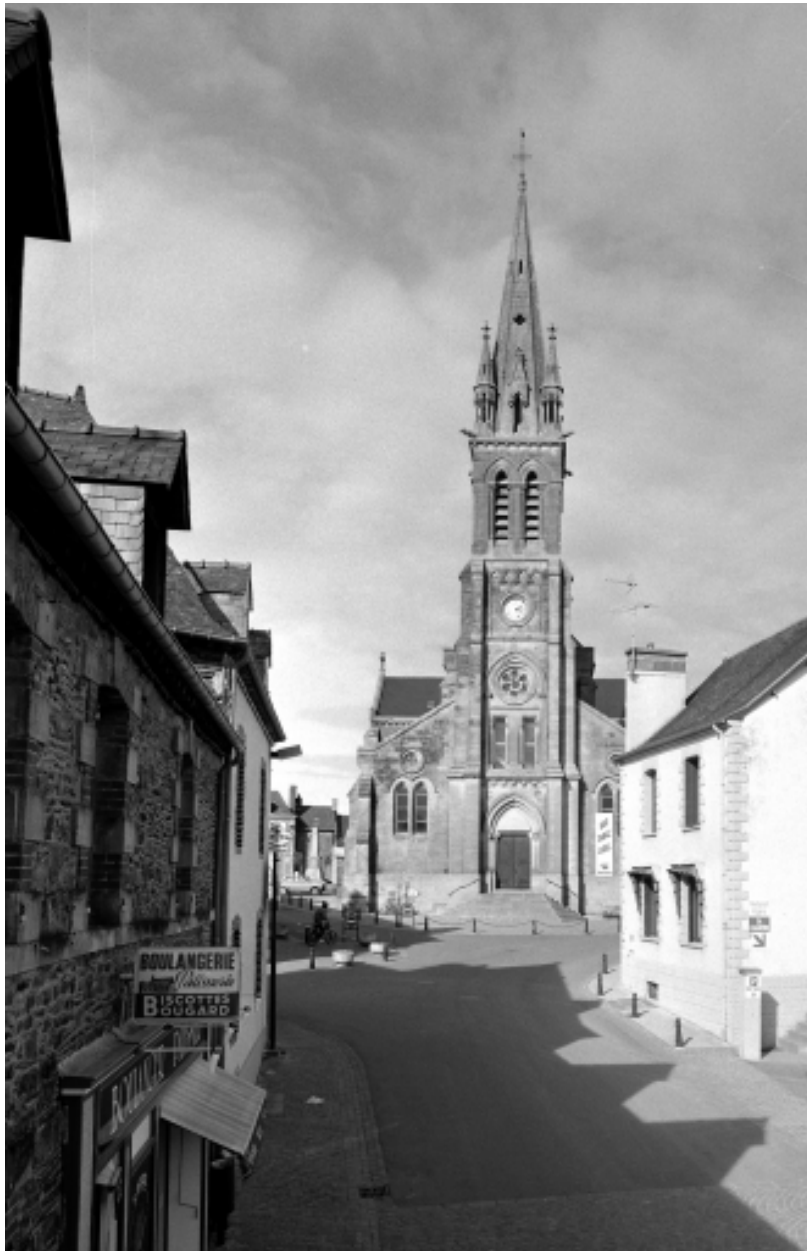
Elévation Sud : vue générale
