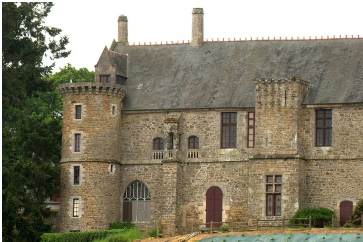
Château, façade donnant sur la Rance, détail
