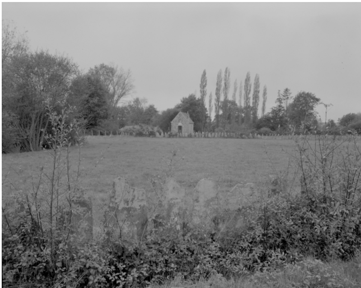
Élévation ouest : vue de situation
