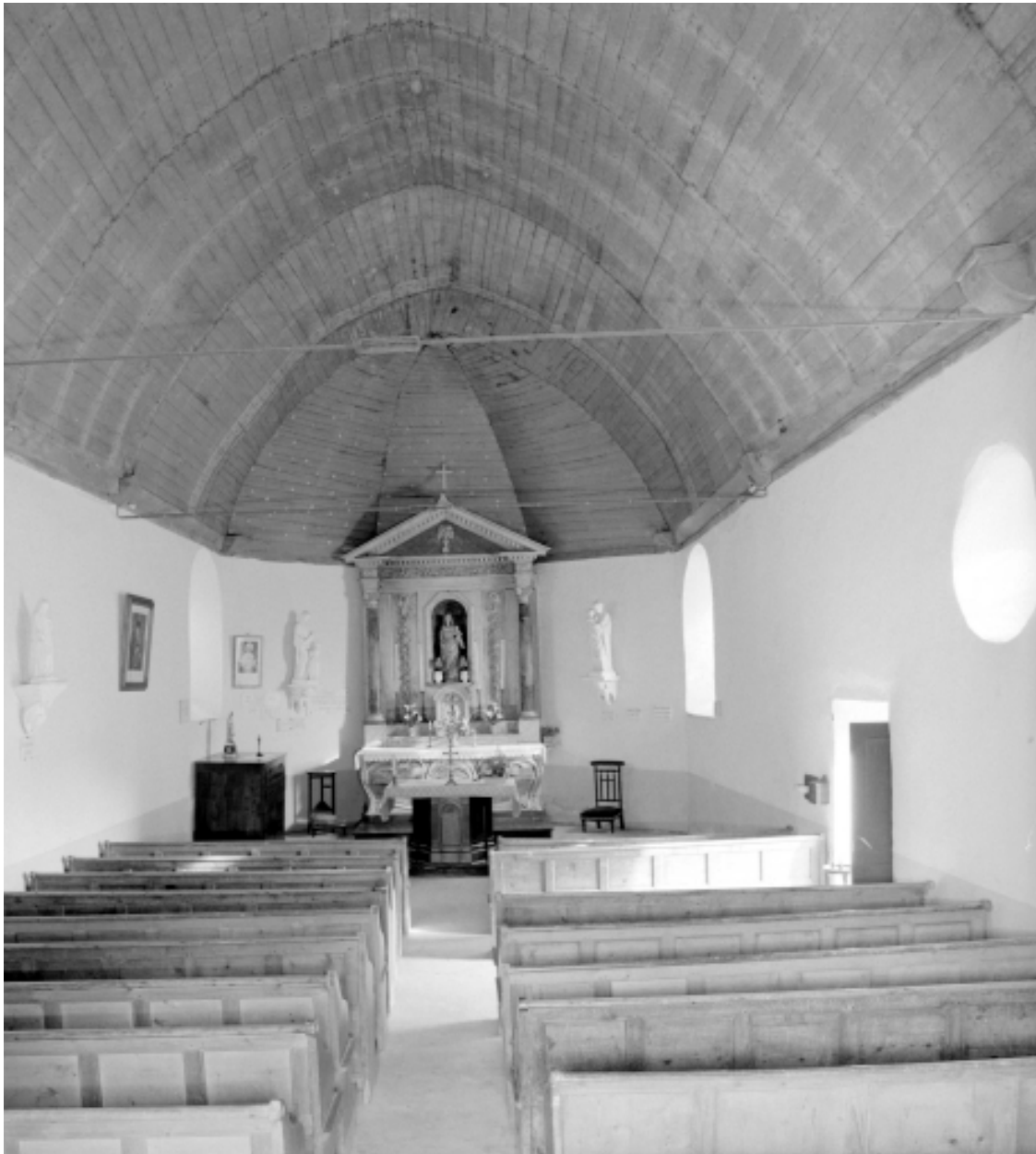
Intérieur : vue générale vers le chœur
