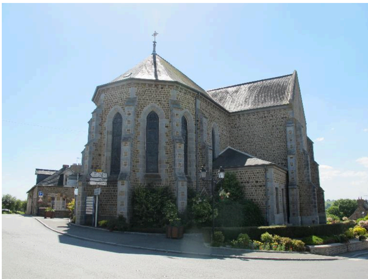
Vue générale : côté nord-est
