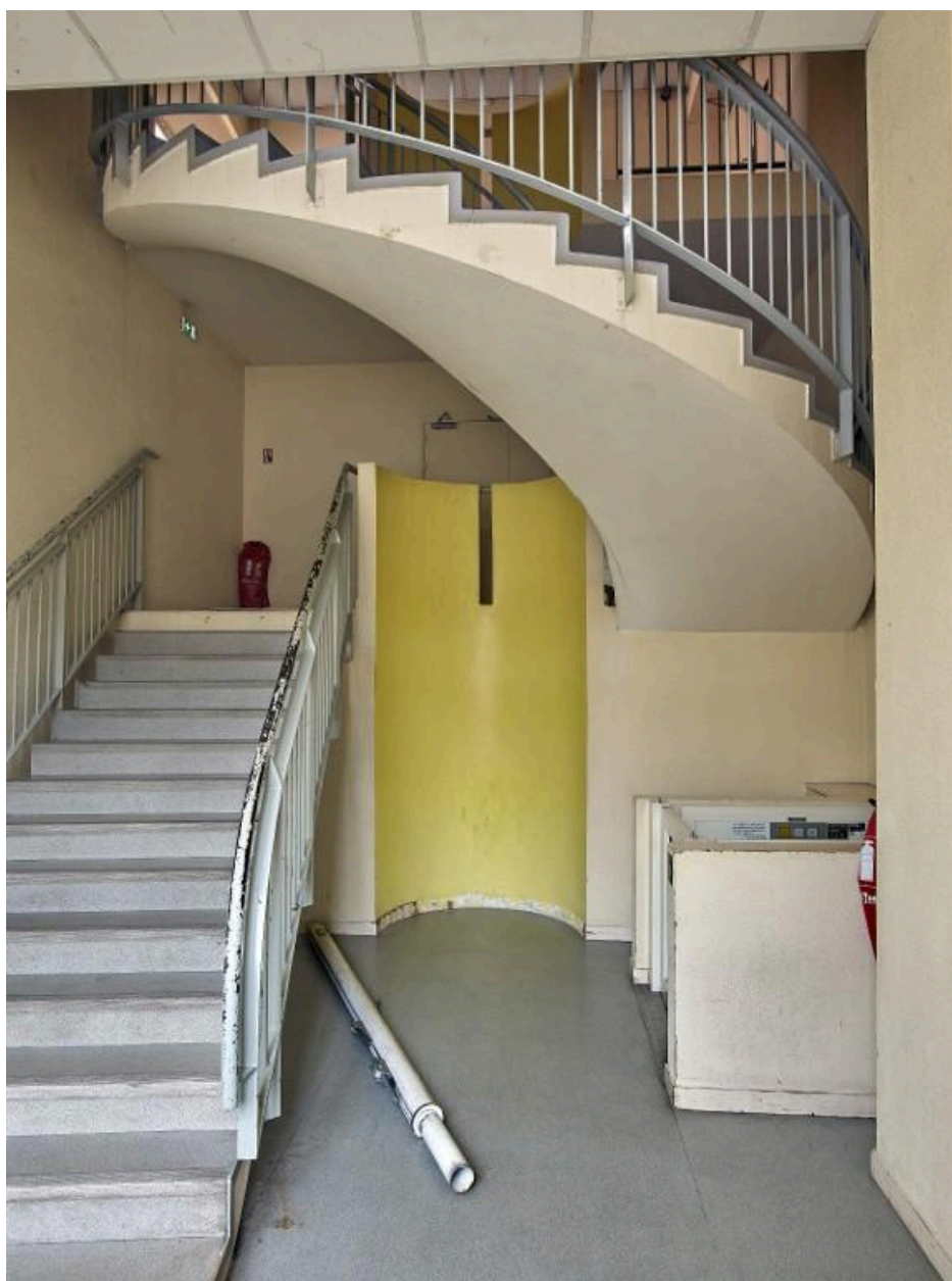
Escalier d'accès à l'étage de la salle de sport.
