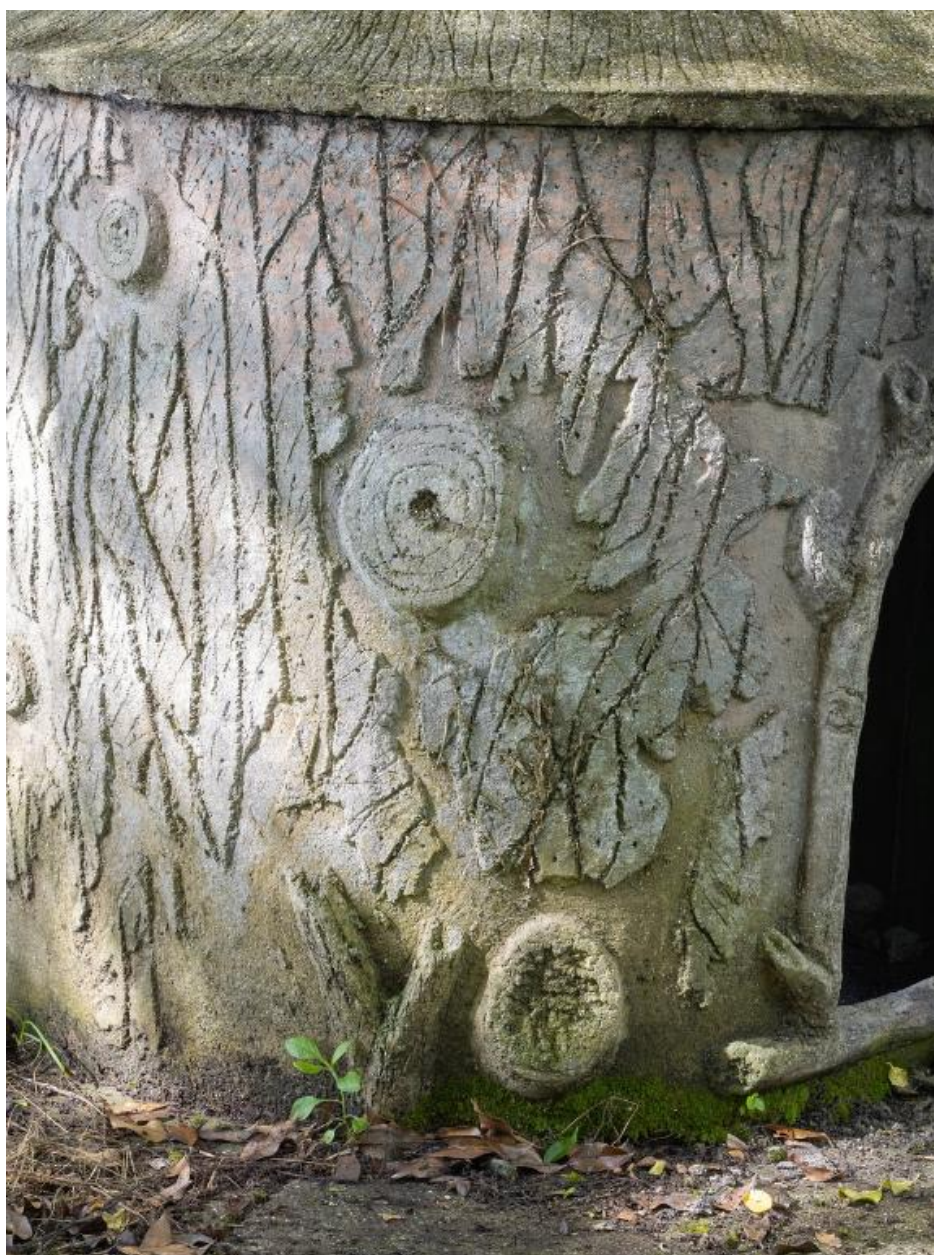
Vue de la niche du chenil : faux bois en ciment armé
