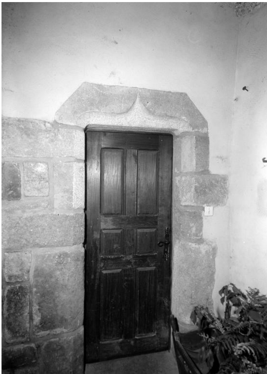
Couloir d'entrée, porte à l'angle sud-ouest de l'escalier nord
