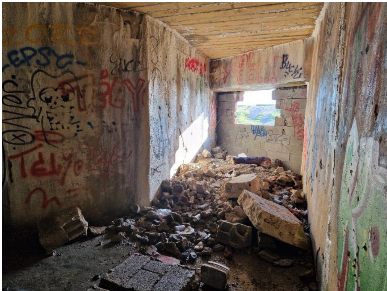
Vue intérieure du bunker - cuve nord pour canon de 34 cm avec magasins de munitions : l'une des deux entrées. Les parpaings sont cassés
