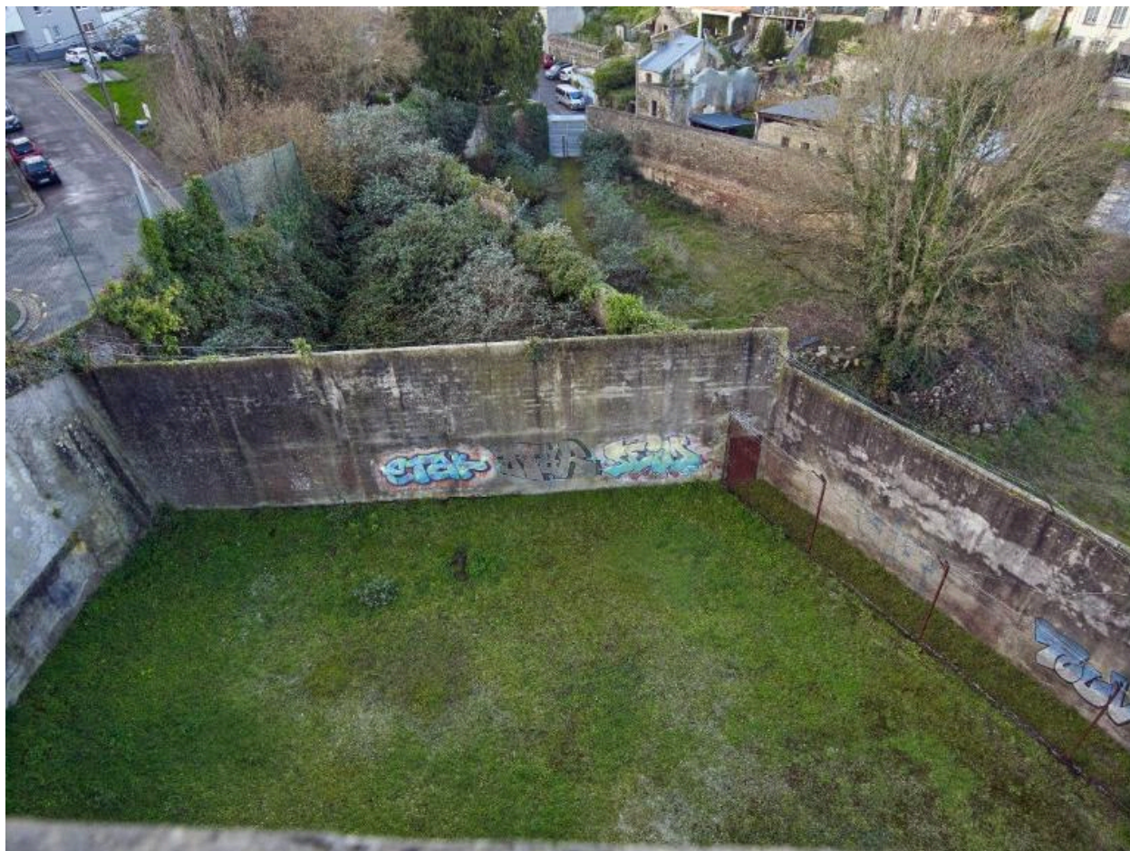
Vue de la cour nord depuis les étages supérieurs de la prison
