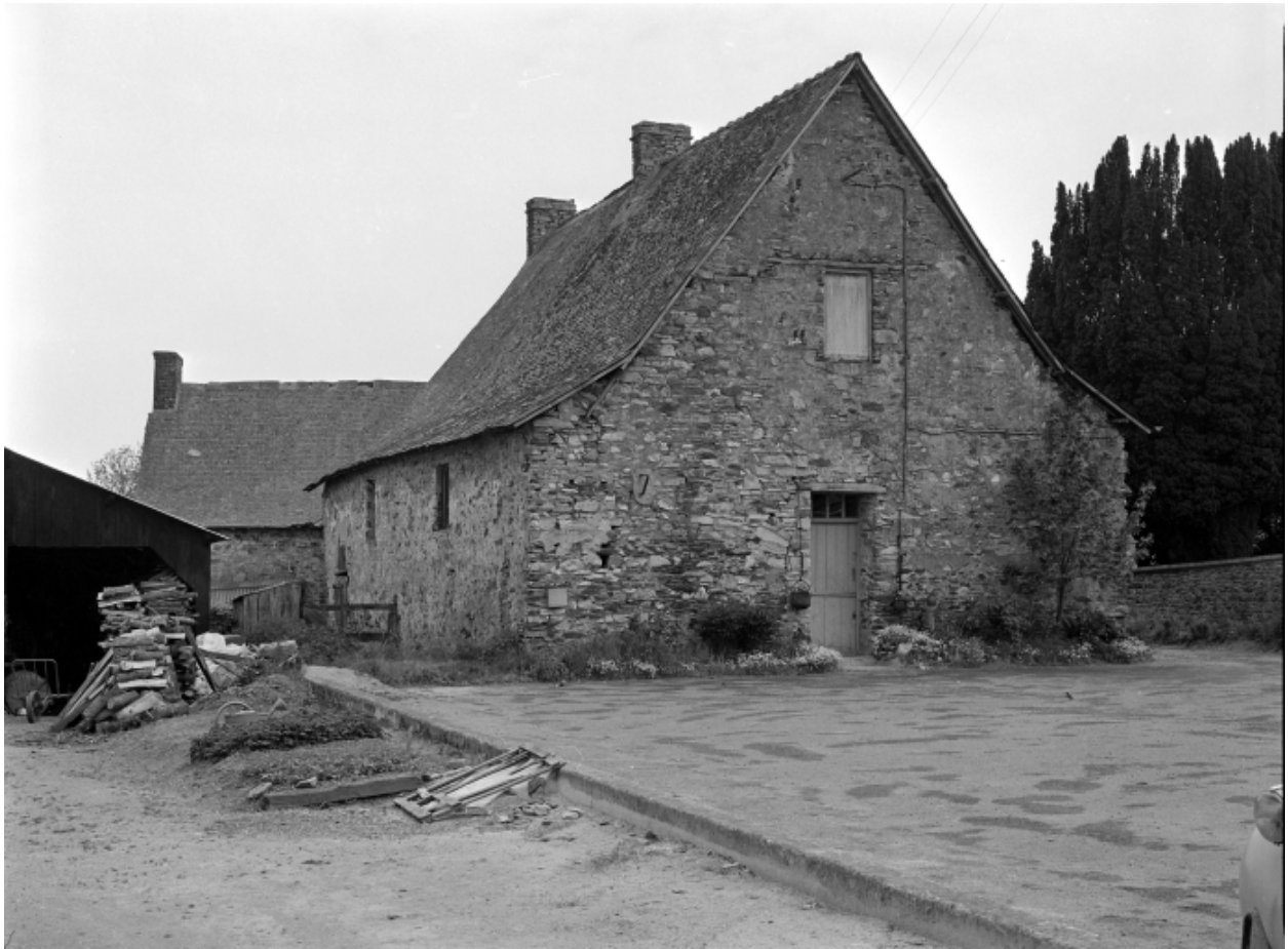
Elévation ouest, vue générale.
