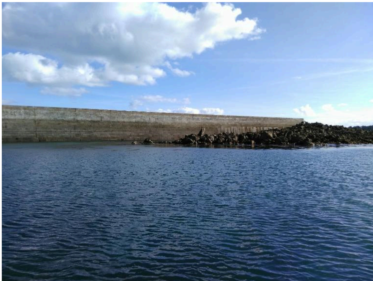
Môle, côté sud, vers le sud
