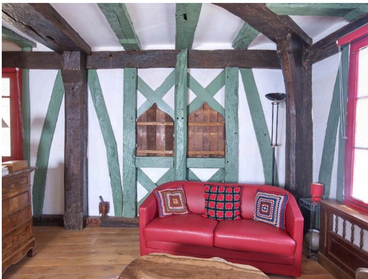
Angle en pan de bois du premier étage, avec des écharpes coudées en contreventement à l'image du 31 Place du Centre (n°48, place du centre).
