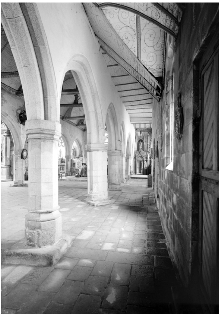
Vue axiale du bas-côté sud de la nef
