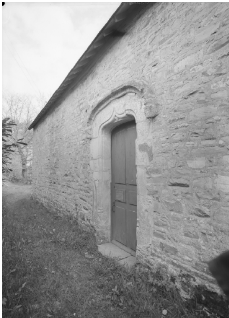
Elévation Nord, porte : vue générale
