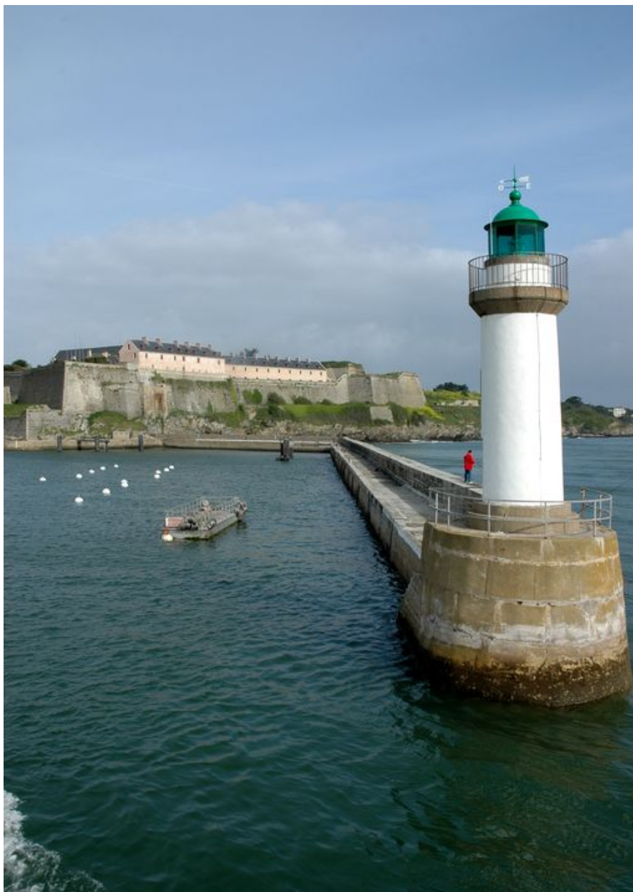
Vue générale de la citadelle de Belle-île
