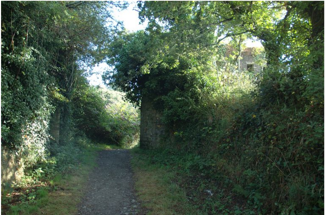
Vue de l'enceinte du fort de mer : porte
