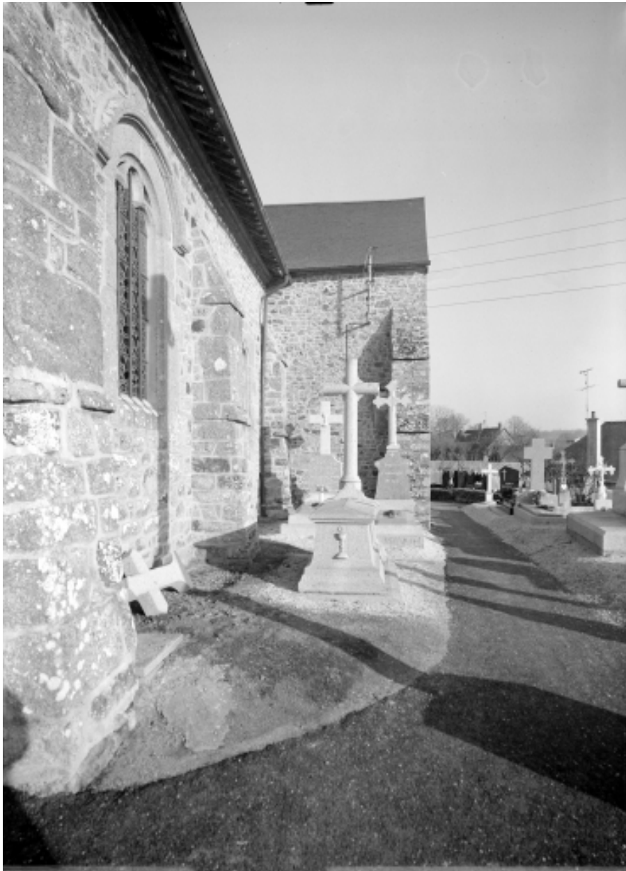
Elévation sud, partie centrale : détail de l'alignement
