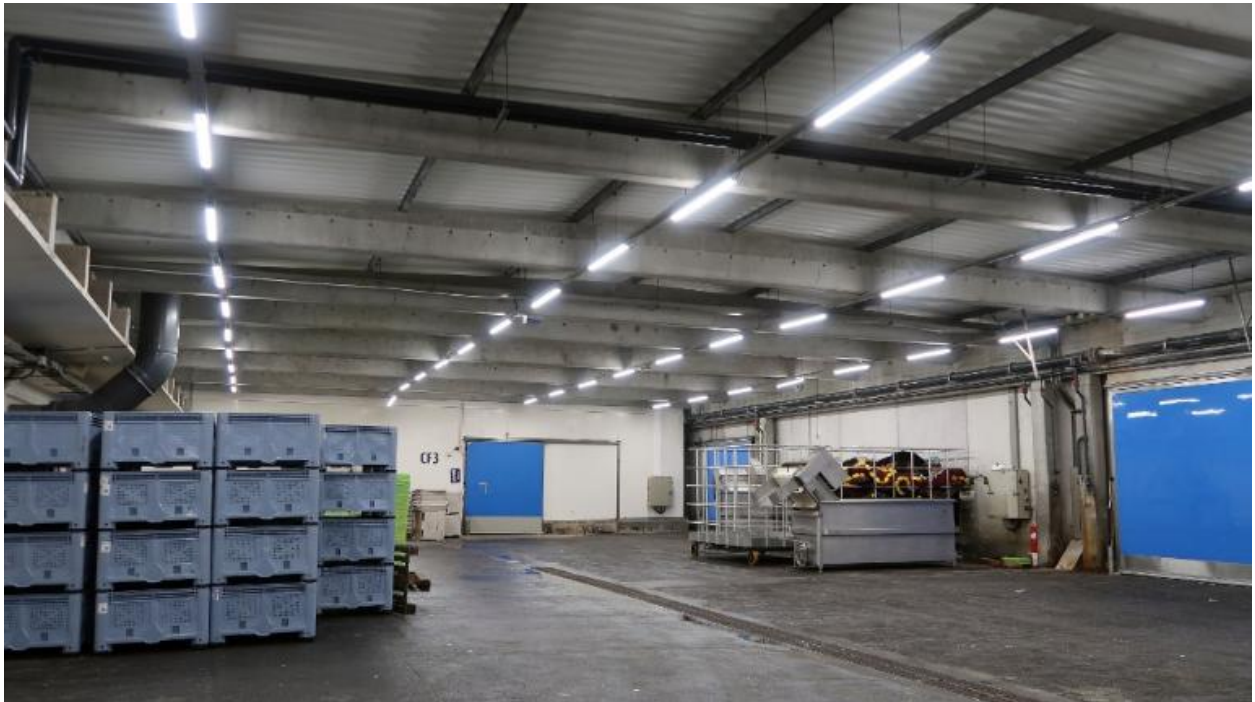
Criée de Concarneau : intérieur, poutrelles béton, zone agrandissement 1991, jonction entre les deux bâtiments
