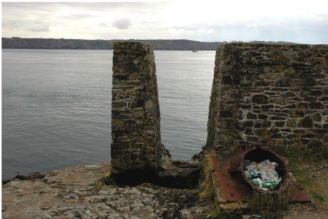
Vue du tube de lancement (état en 2006)
