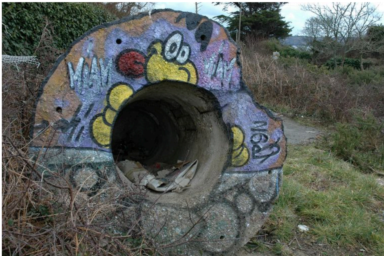
Vue d'une guérite en béton armé : elle est basculée (état en 2005)
