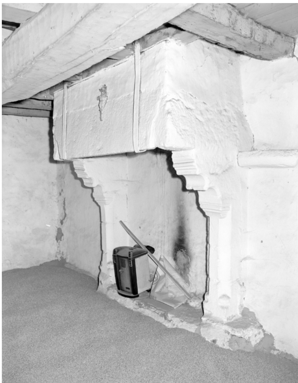
Cheminée, étage, mur est
