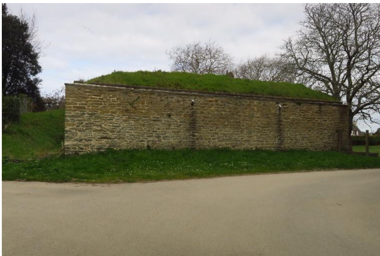
Le Palais, enceinte urbaine, réduit C, flanc gauche.
