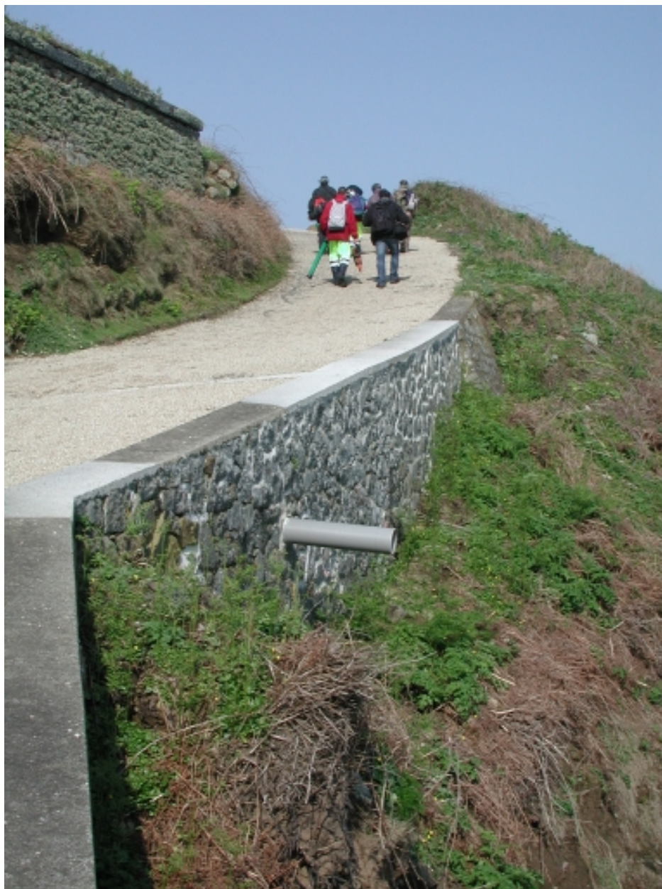
Le mur de quai refait avec barbacane moderne
