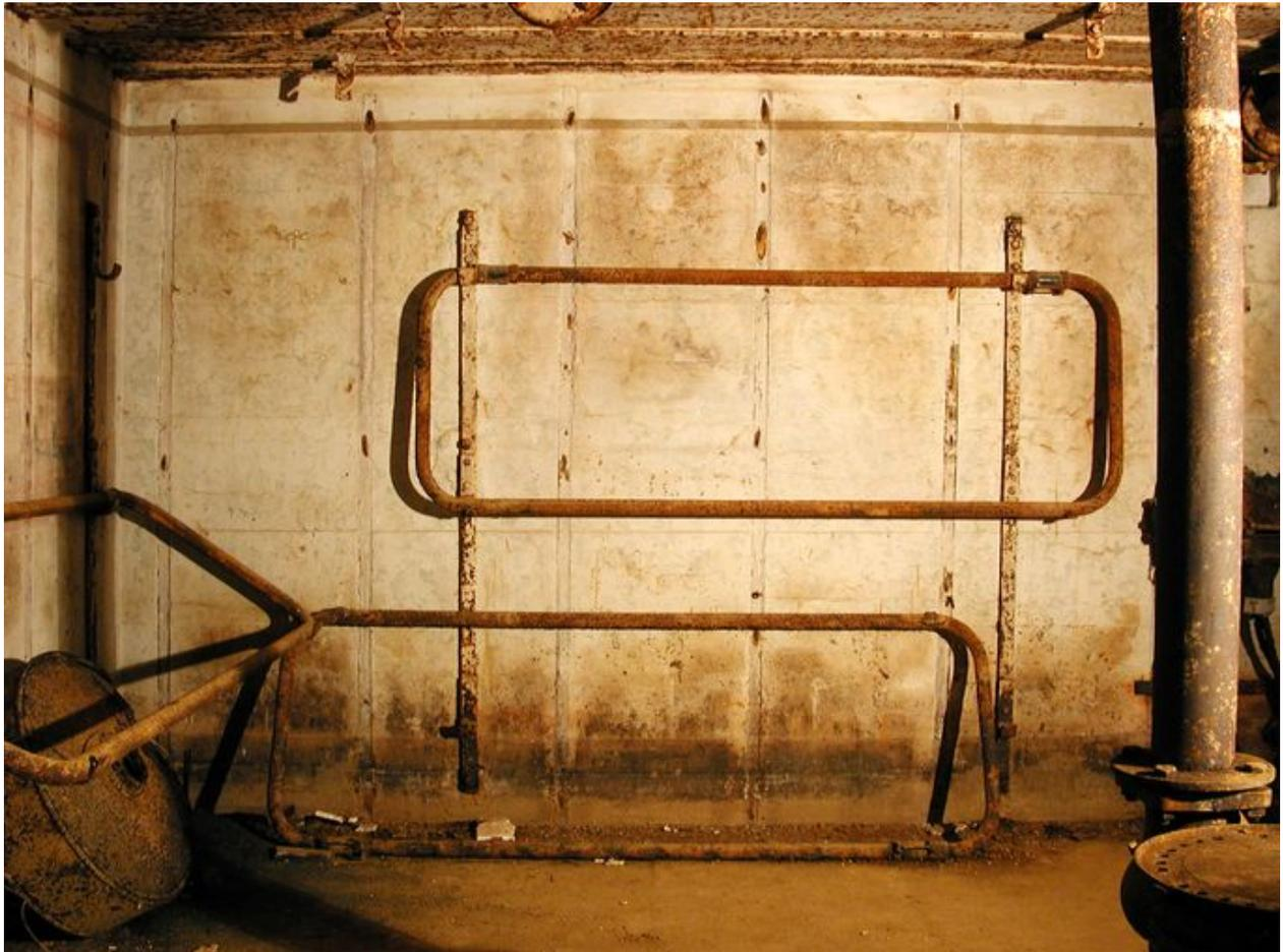
Vue de la chambre de troupe droite : lits - couchettes superposées, tuyau du poêle (premier plan), filtre de ventilateur à charbon (sur le sol, à gauche)
