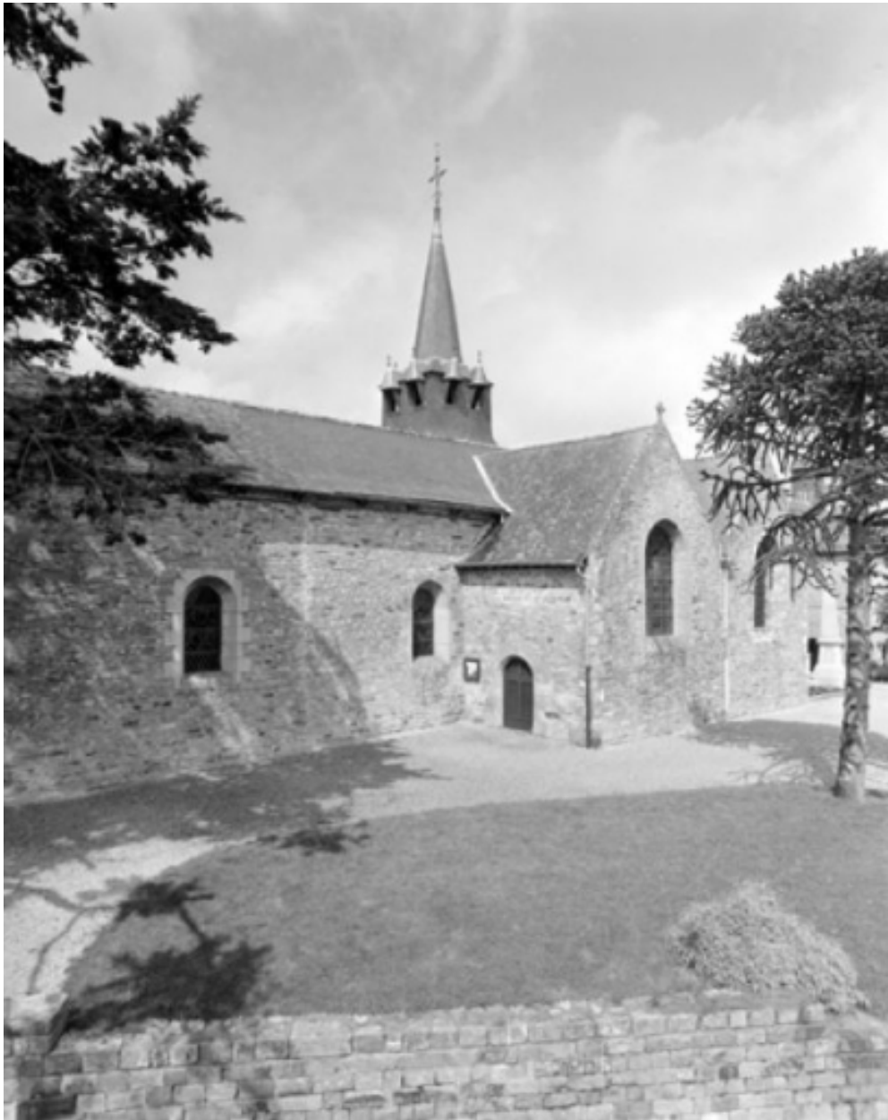
Elévation sud : vue générale
