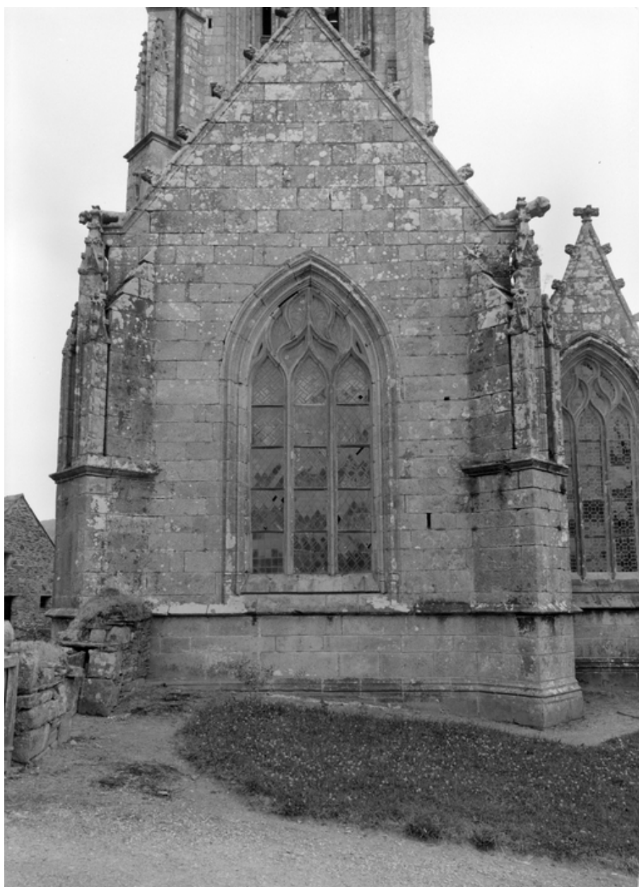
Façade sud, fenêtre sud de la chapelle sud-ouest
