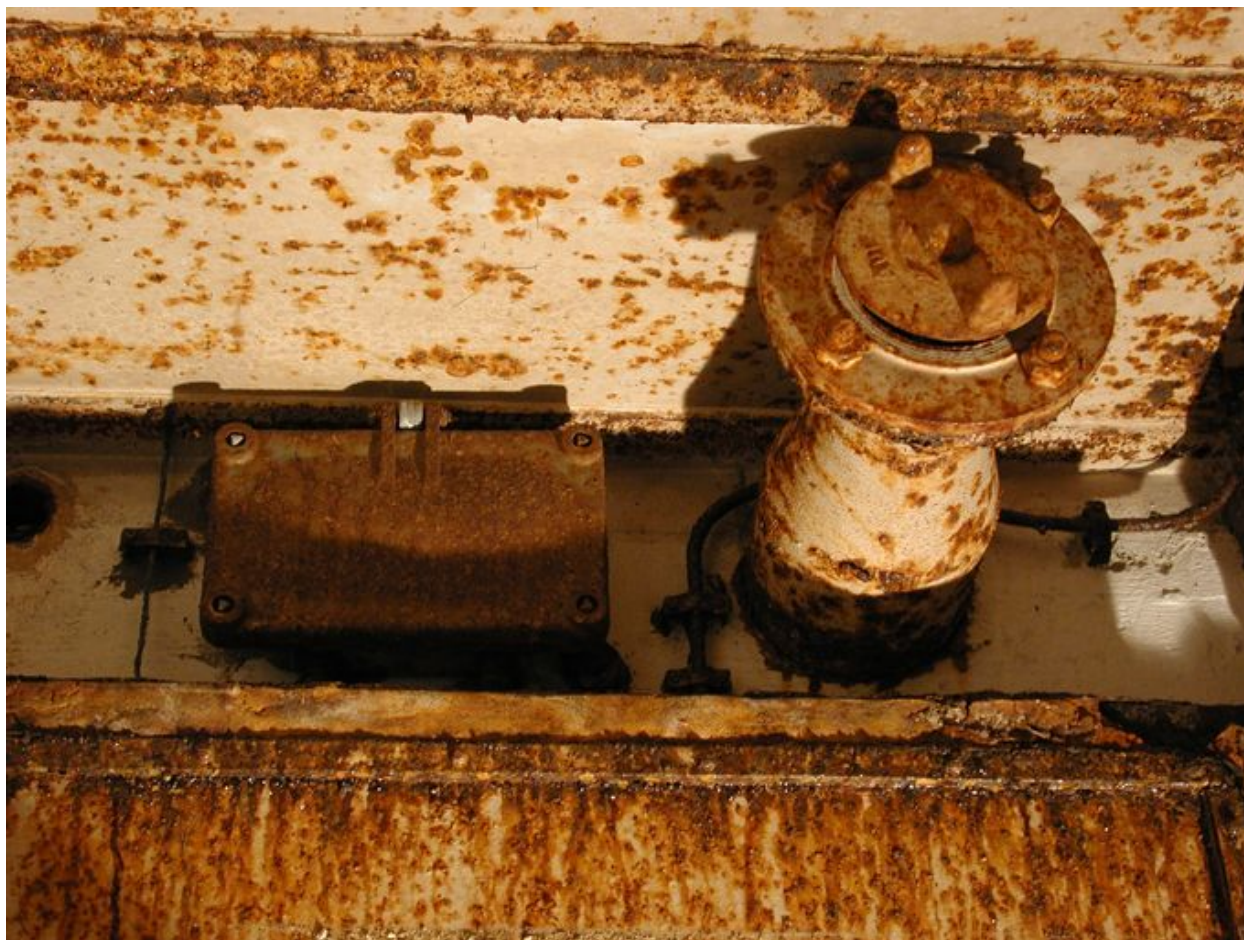
Poste d'observation/petite pièce latérale, détail d'un boîtier (électrique ?)
