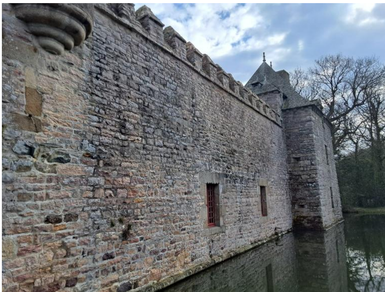
Château de Bienassis_pavillon d'angle ouest de l'enceinte
