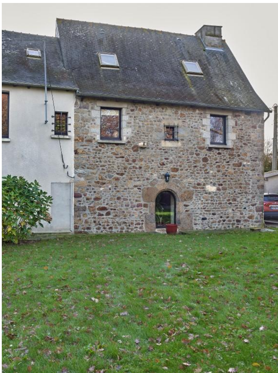
Façade arrière nord
