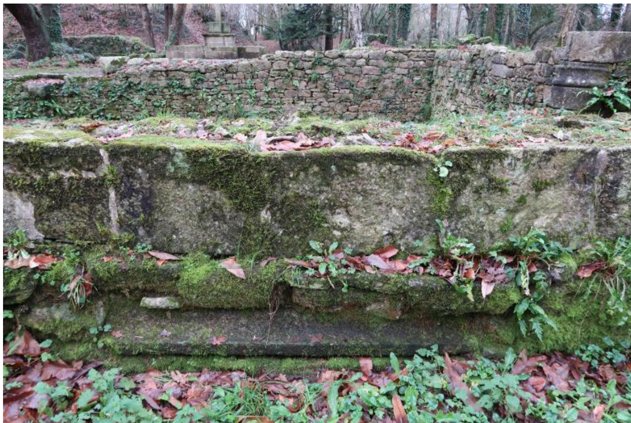
Vue de détail de l'élévation sud (bas-côté)
