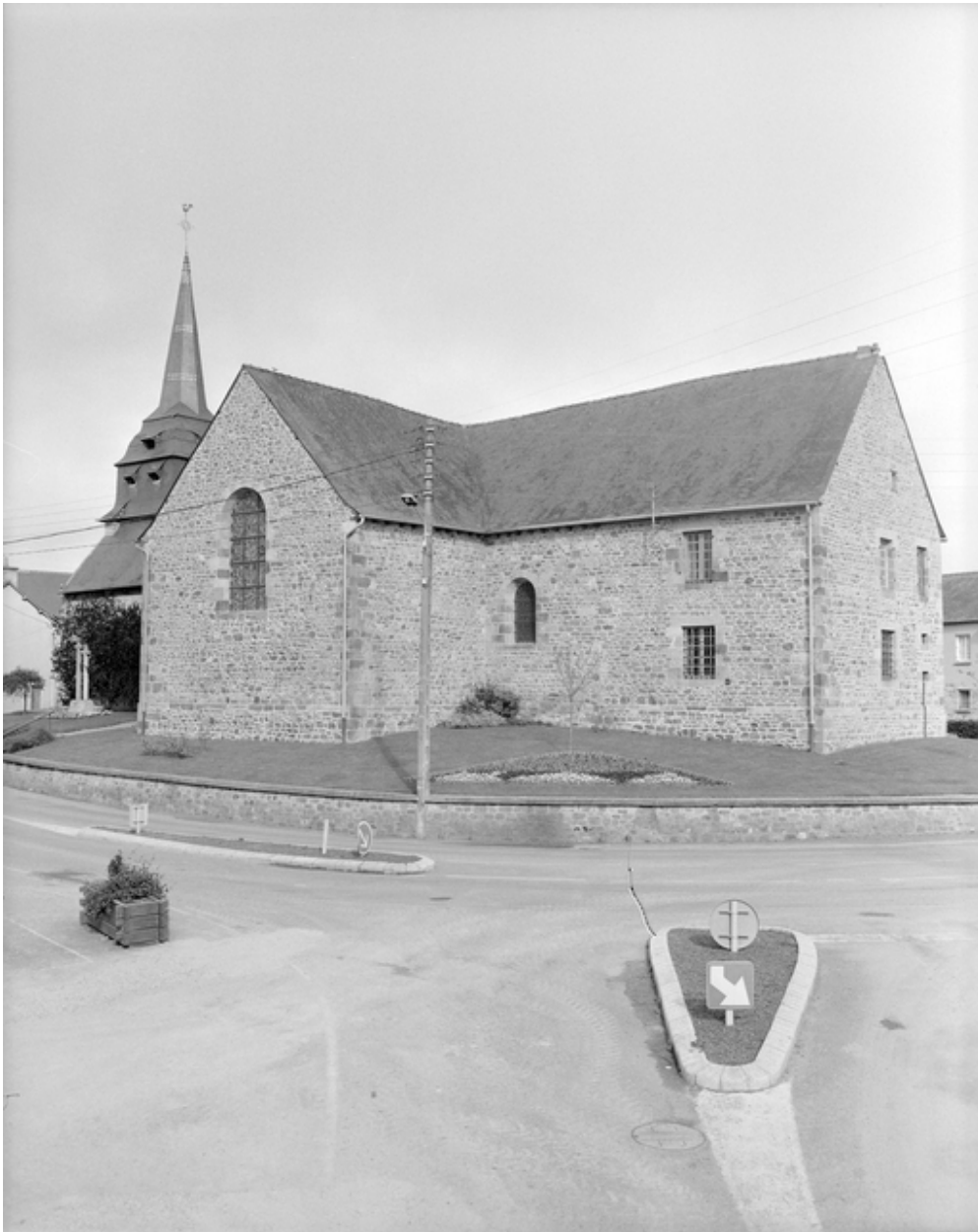
Elévation Nord-Ouest : vue générale
