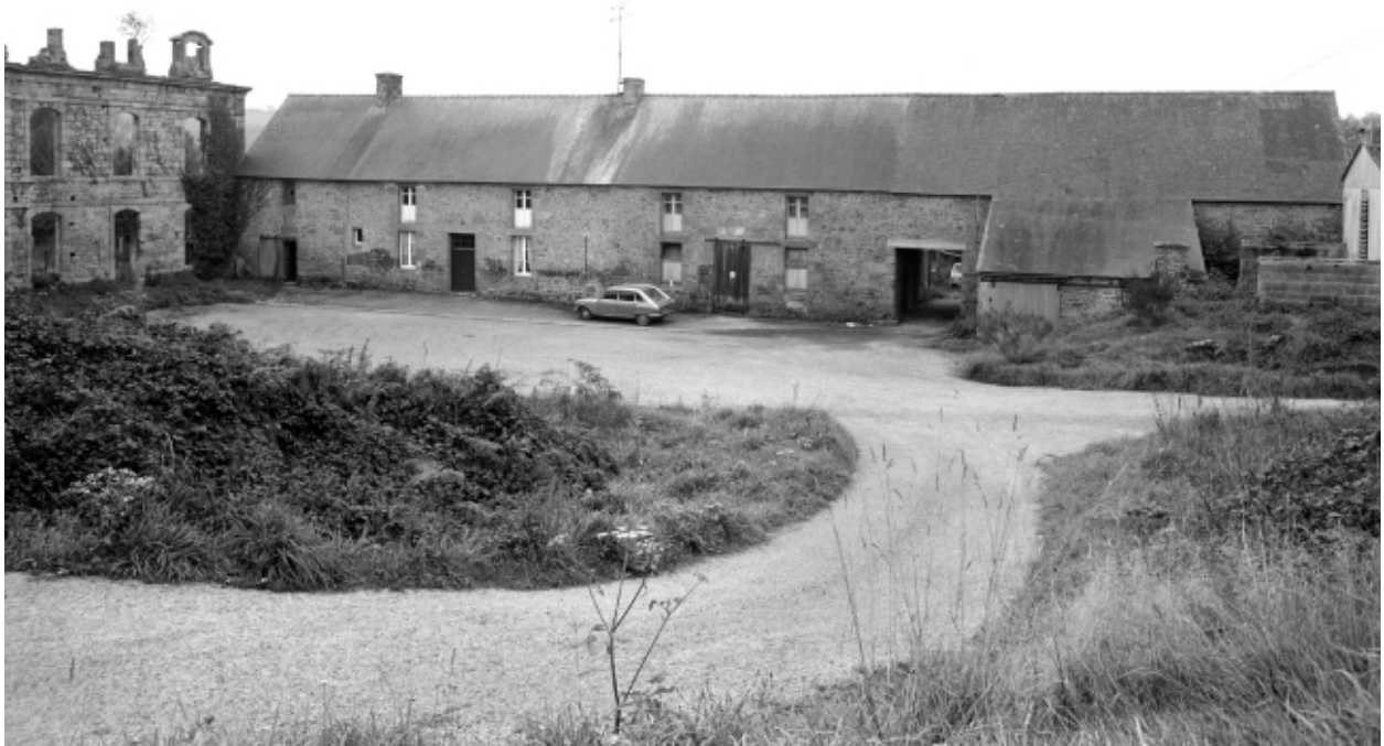
Communs au sud-ouest du logis, abbatale, élévation nord
