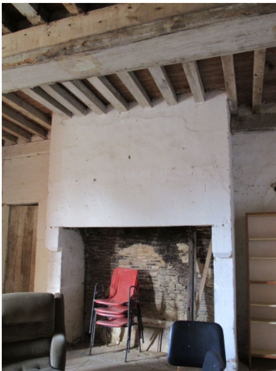
Cheminée de l'étage du logis
