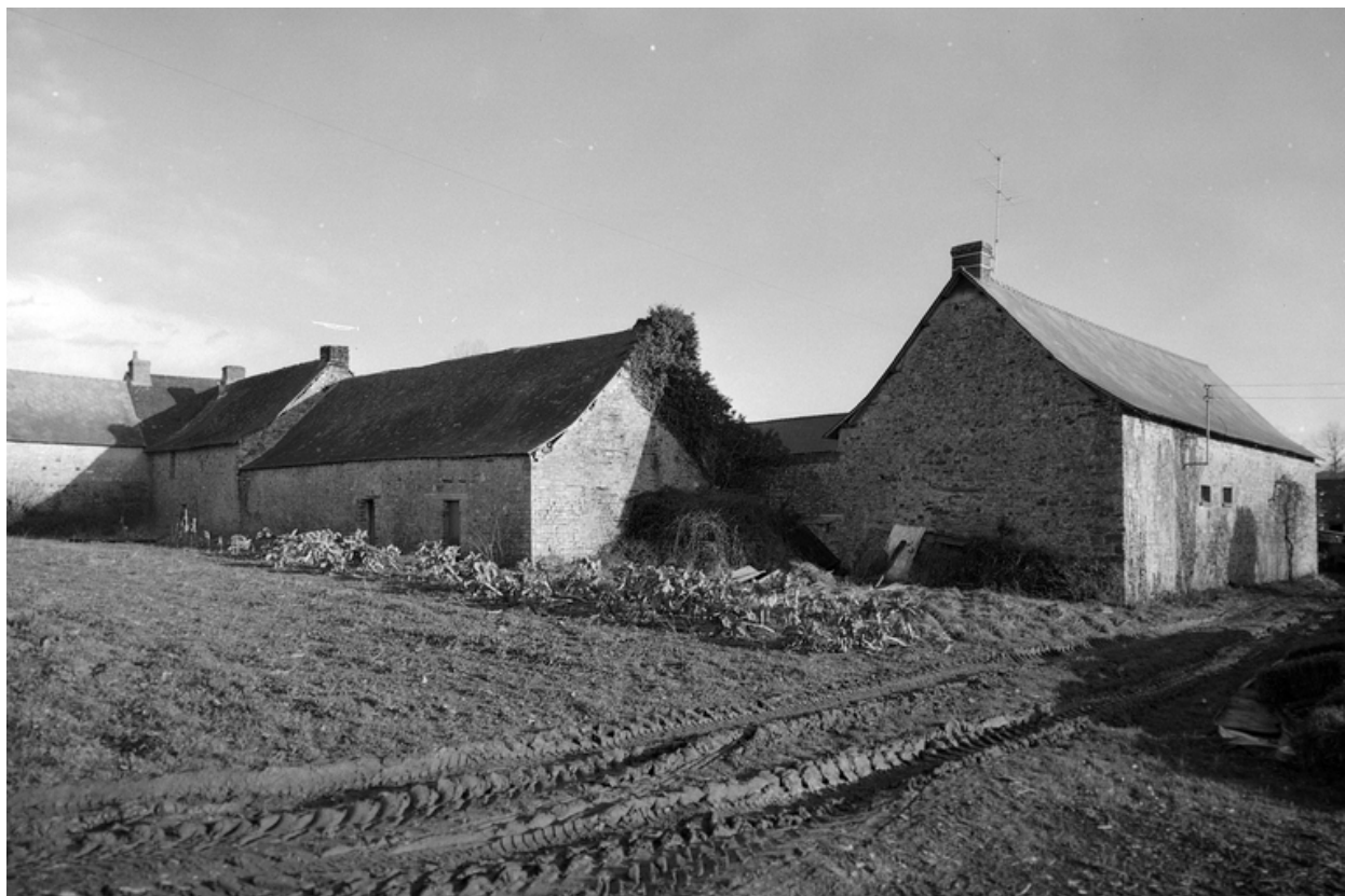
Vue de situation prise du nord ouest.
