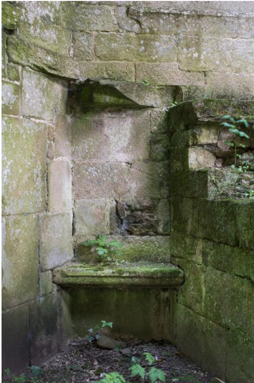
Le château : vue intérieure de la tour d'escalier
