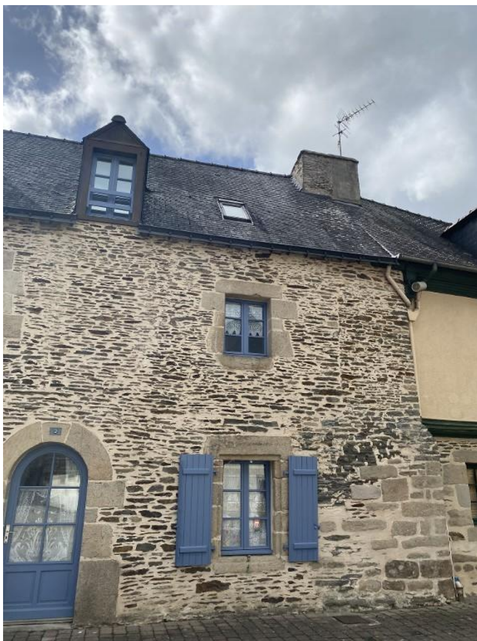
façade est, détail
