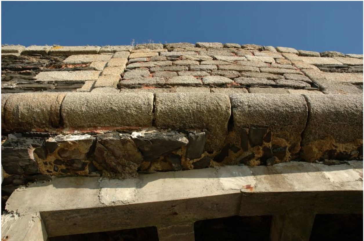
Vue de la batterie de Cornouaille : détail de l'escarpe (mur de soutènement de la batterie). Encadrement des créneaux, et cordon en granite ; remplissage en moellons de schiste (Travaux de stabilisation réalisés par la Direction des Travaux Maritimes)
