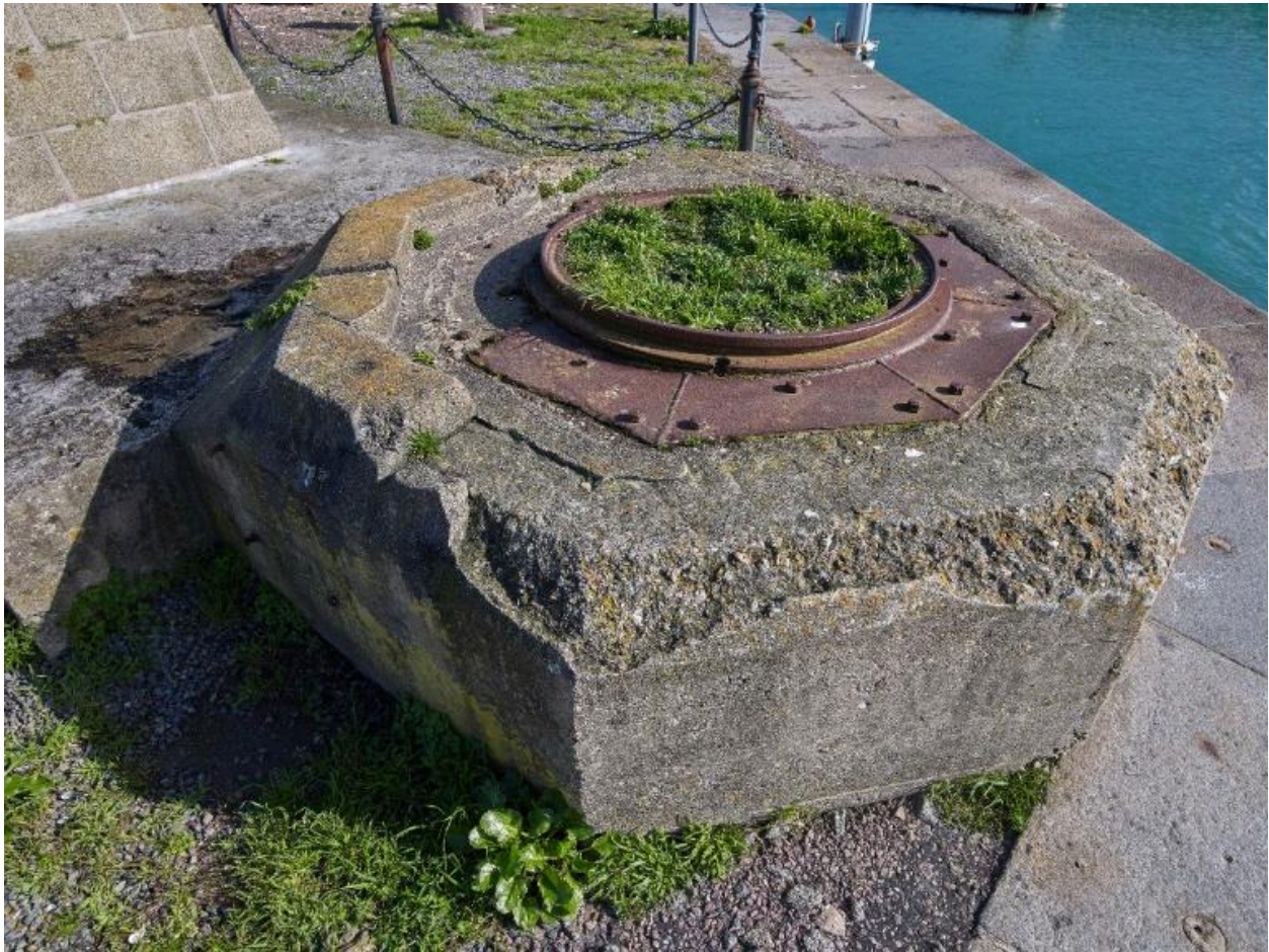
Vue de détail : chemin de roulement de la tourelle de char de combat
