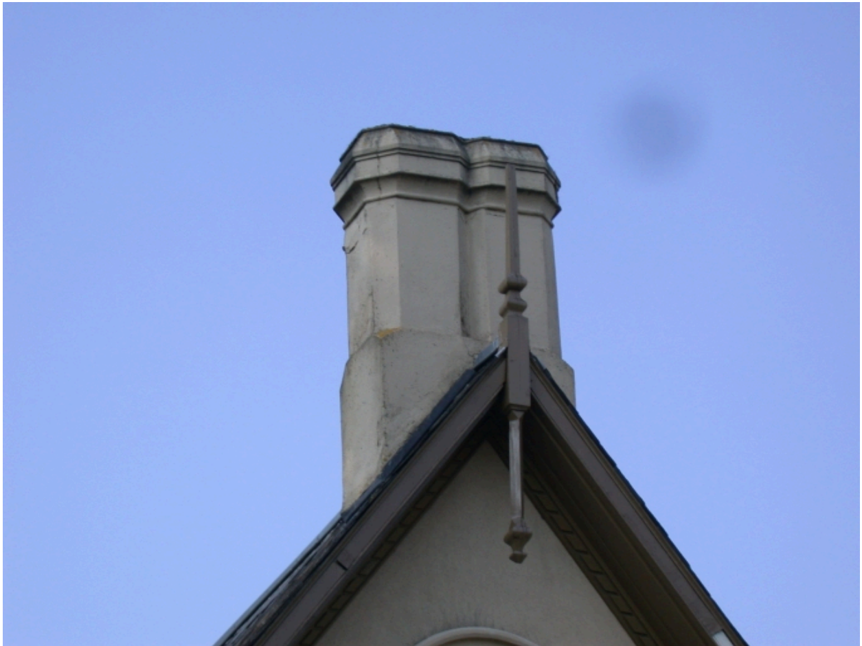
Détail des souches de cheminée
