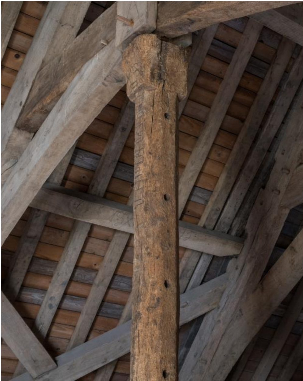
Vue oblique de la partie haute du pignon de la ferme orientale de la charpente du choeur.
